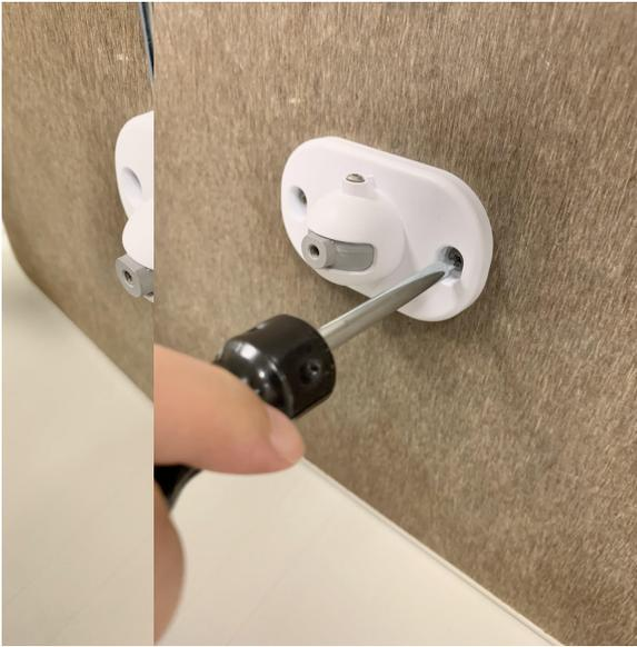
Pour monter le détecteur 862EX avec le support de montage rotatif:
